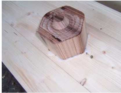
Der zentrale Nocken mit der konischen Führung erlaubt die Montage im-Steckverfahren - Stab für Stab
