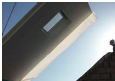
Montagetermin auf der Baustelle.
